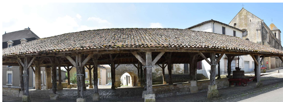
Photographie 45 : Les halles (MH n°54) et l'église de Pamproux (MH n°56)
