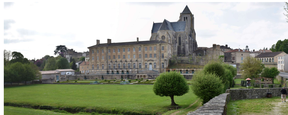
Photographie 55 : Ensemble architectural composé de l'abbaye royale et de l'église paroissiale de Saint-Hilaire.
