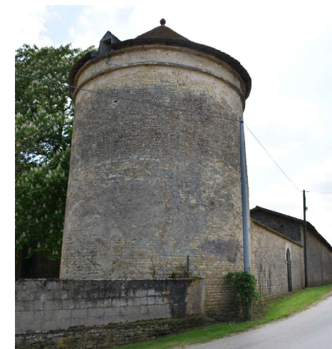
Photographie 38 : Donjon à Messé (MH n°22)
