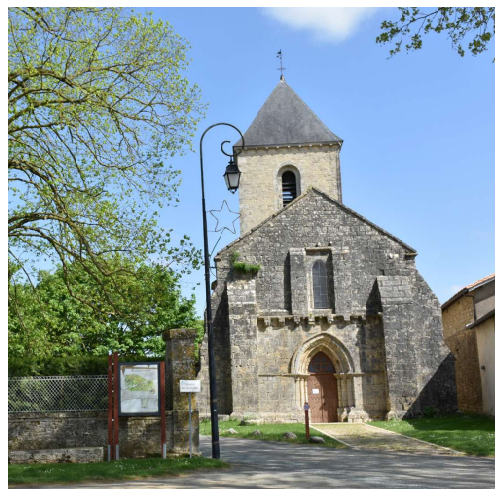
Photographie 36 : Eglise Saint-Martin à Vançais (MH n°15)
